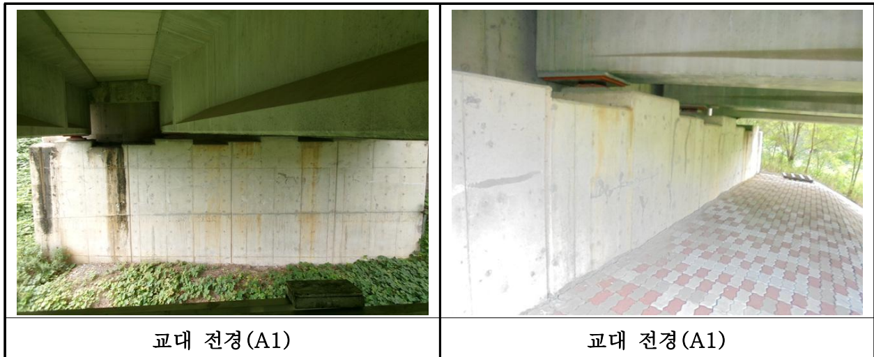
【사진 13.3.33】 교대 전경
