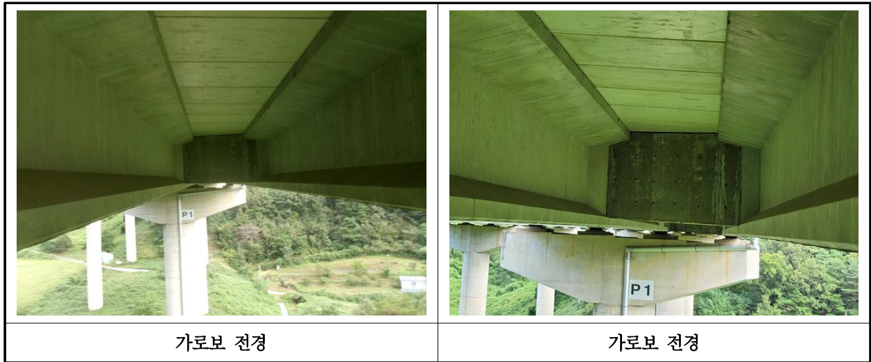
【사진 13.3.31】 가로보 전경
