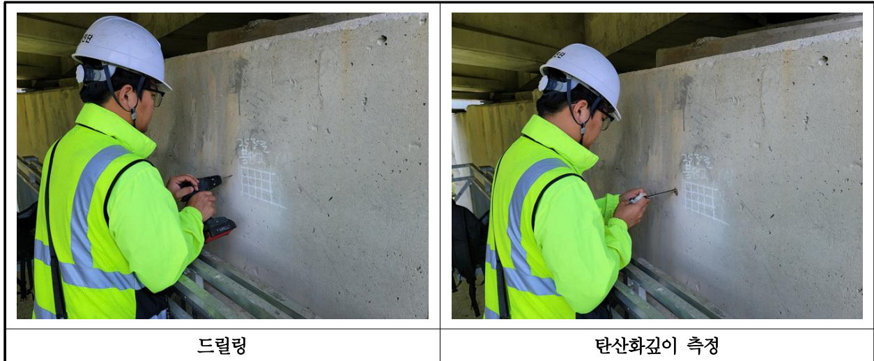
【사진 13.4.3】 탄산화 깊이 측정 현장사진
