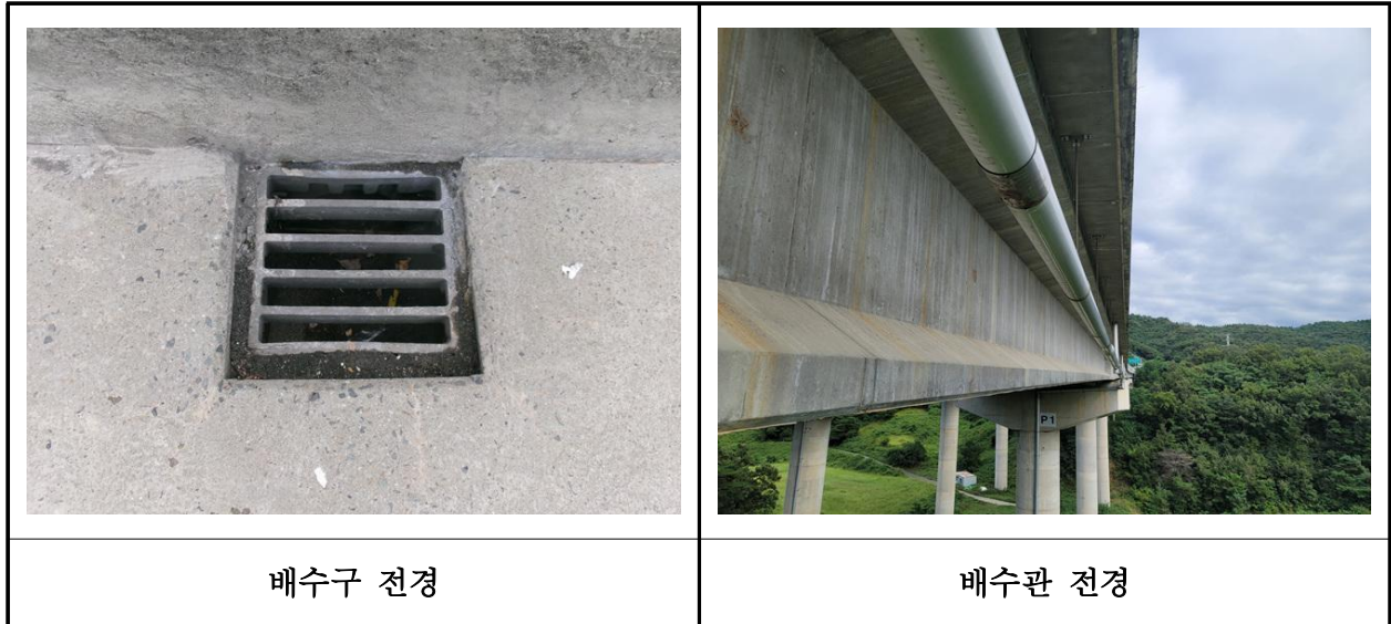
【사진 13.3.47】 배수시설 전경
