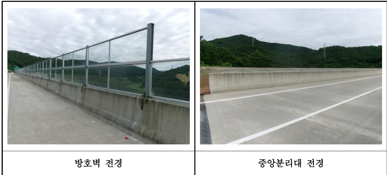
【사진 13.3.49】 방호벽 및 중앙분리대 전경
