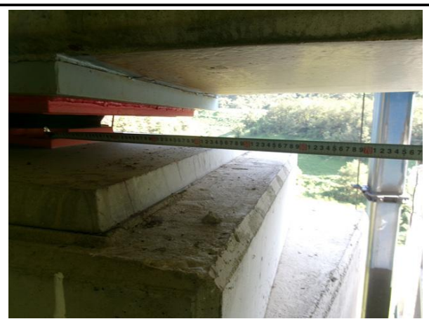
받침장치 연단거리 측정(2)
