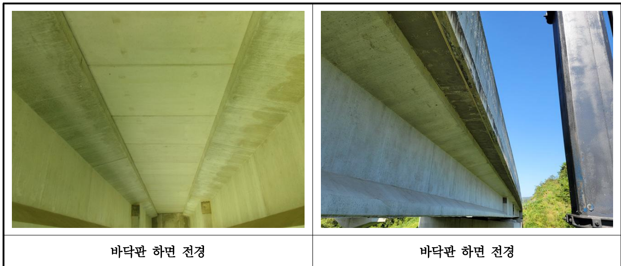
【사진 13.3.2】바닥판하면 전경
