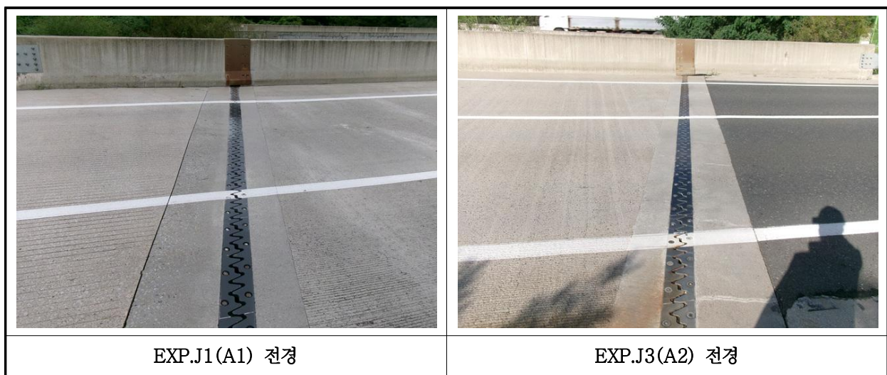
【사진 13.3.42】 신축이음장치 전경
