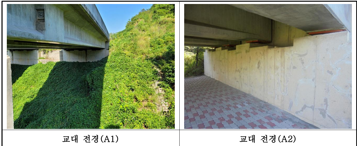
【사진 13.3.8】 교대 전경
