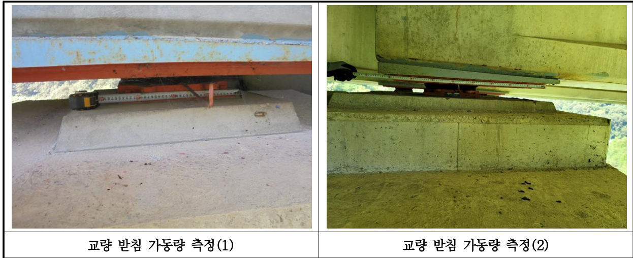
【사진 13.3.16】 교량받침 이동량 측정
