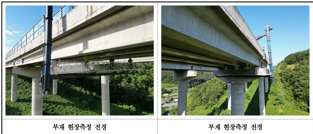
【사진 13.2.1】 부재 현장측정 전경
