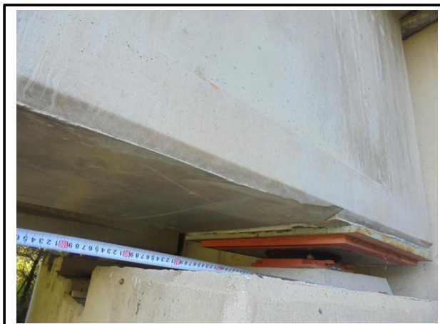
받침장치 연단거리 측정(1)
